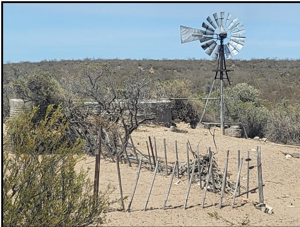
FOTO N° 4: Molino y tanque de almacenamiento de agua en uso
